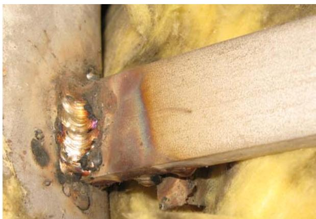
**Bild 2:** Anlauffarben bei einem Anschweißanker
